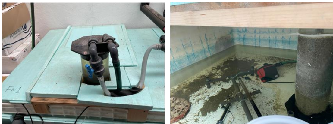
Figura 14- Vista exterior e interior da sump do Sistema I.
