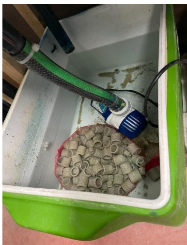
Figura 33- Sump do Sistema de Quarentena de água doce.
