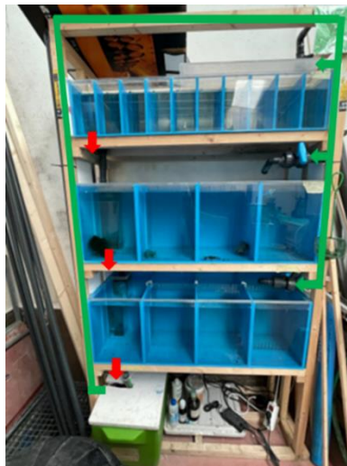
Figura 32- Esquema de circulação hidráulica do Sistema de Quarentena de água doce com a linha de retorno (seta a verde) com respetivas válvulas de controlo os tubos de drenagem (setas a vermelho).
