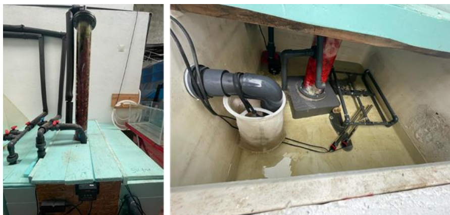
Figura 25- Vista exterior e interior da sump do Sistema III.
