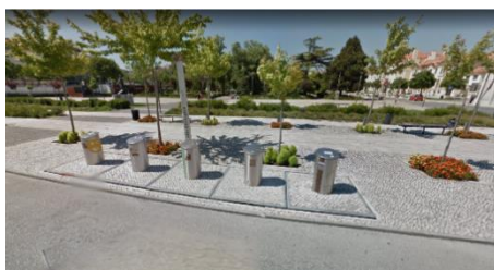
Figura 3.30 – Exemplo de contentorização subterrânea com acabamento em calçada portuguesa
