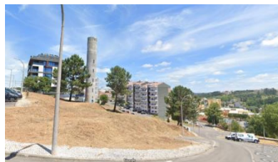
Figura 3.21 – Reservatório de água elevado existente na área do PPVC
