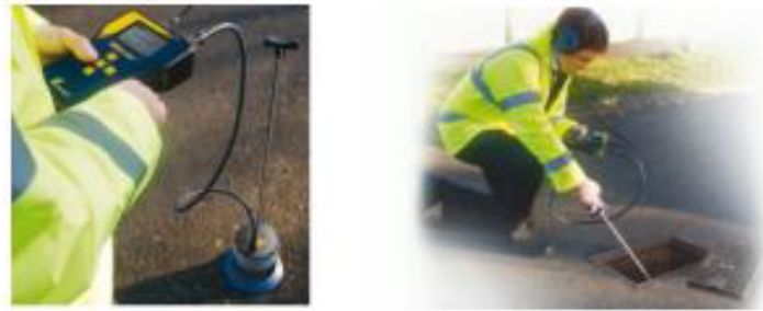
Fig. 37 Inspección con geófono en tuberías de distribución de agua potable
