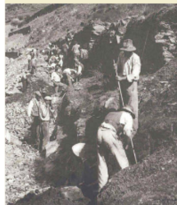
1 ► Trabalhos no campo.
