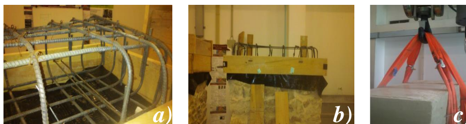
Figura 46 – Execução do lintel: a e b) colocação da armadura e tela asfáltica; c) aplicação do ligante epoxi.
