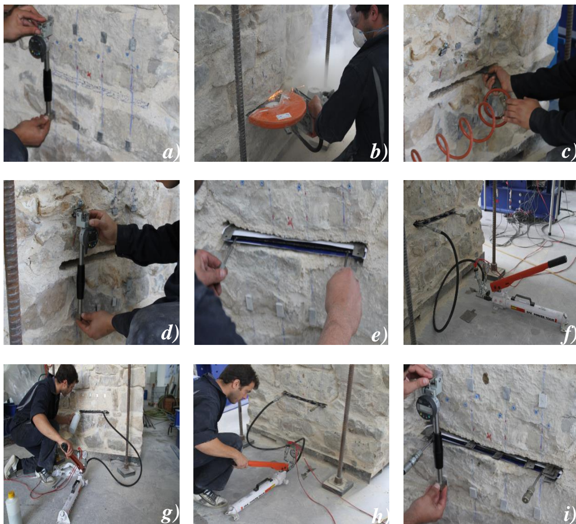
Figura 54 – Protocolo utilizado no ensaio simples em laboratório: a) leitura das dist. 's iniciais; b,c) abertura e limpeza do rasgo; d) leitura das dist. 's após abertura do rasgo; e) introdução do conjunto macaco-químico no rasgo; f) ligação do sistema hidráulico; g) purga do macaco; h) incrementos de carga para reposição das distâncias iniciais; i) leitura das dist. 's após incrementos de carga.
