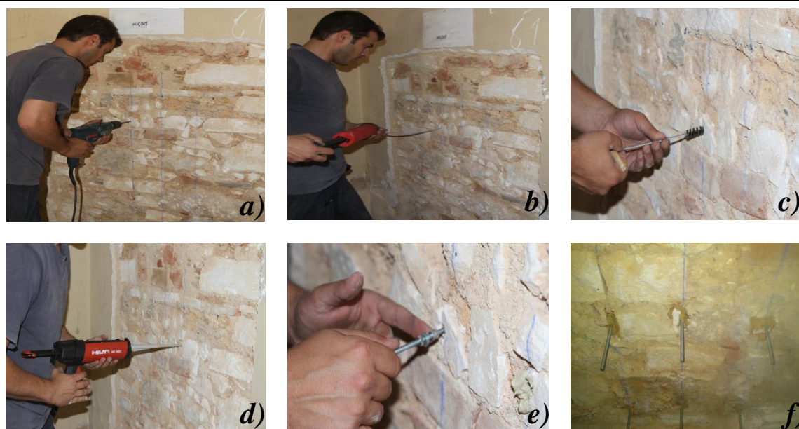
Figura 17 – Aplicação dos varões de suporte aos sensores para ensaio simples e duplo: a) furação para aplicação do químico; b,c) limpeza dos furos; d) aplicação do químico; e) colocação dos varões de suporte dos sensores; f) aspeto janela inspeção após fixação dos varões.
