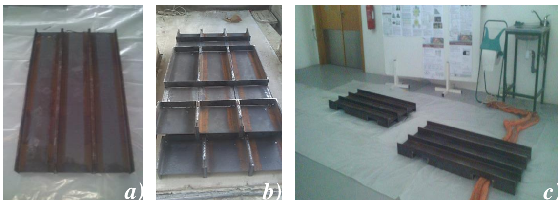
Figura 44 – Preparação da base das paredes: a) três perfis metálicos IPE200 soldados; b) reforço dos perfis metálicos; c) sistema de transporte das alvenarias.
