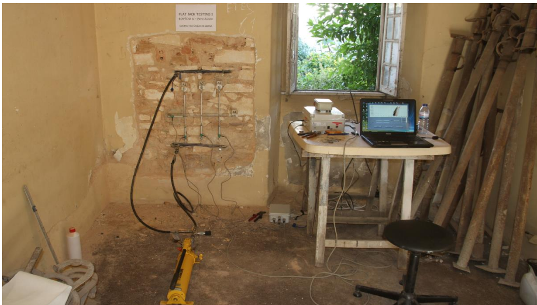
Figura 23 – Perspetiva geral da utilização da técnica de macacos planos - ensaio duplo.
