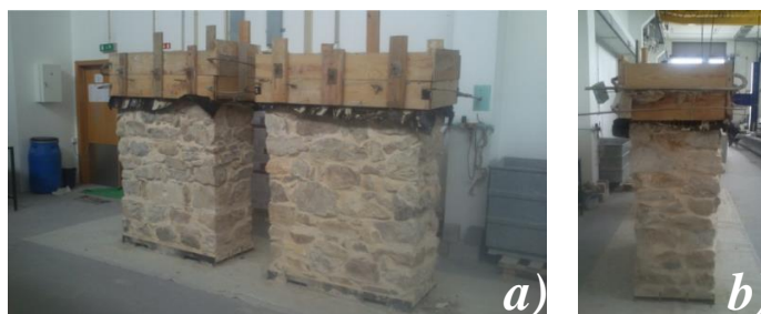
Figura 45 – Execução das cofragens dos lintéis: a) alçados frontais; b) alçado transversal.
