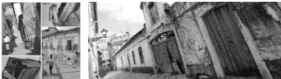
(Exemplos de edifícios a necessitarem de uma urgente intervenção) [Jornal de Leiria]
