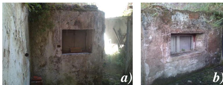
Figura 33 – Identificação de uma das paredes demolidas: a) alçado frontal; b) alçado posterior.
