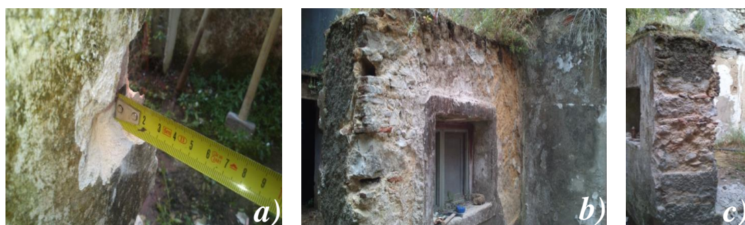
Figura 34 – Primeira fase de demolição da parede: a) espessura do reboco; b) remoção do reboco do alçado posterior; c) remoção do reboco da seção transversal.
