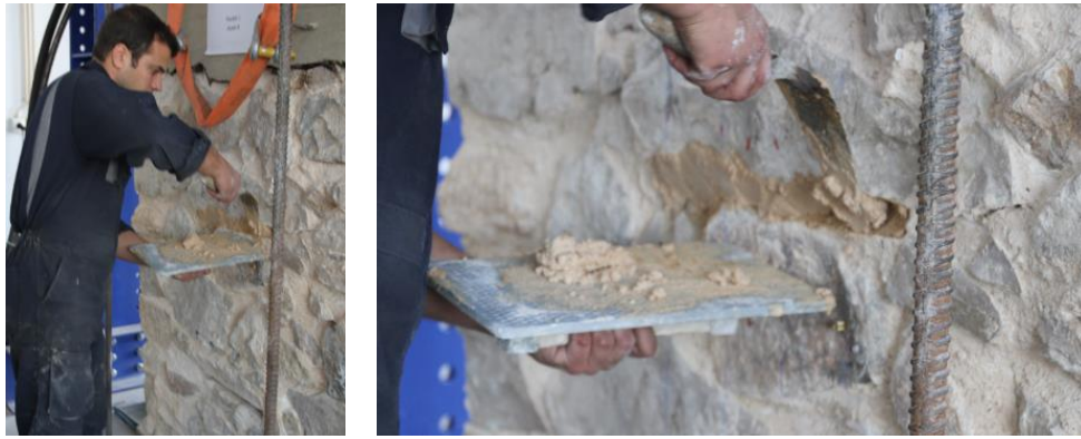
Figura 59 – Preenchimento dos rasgos com argamassa.
