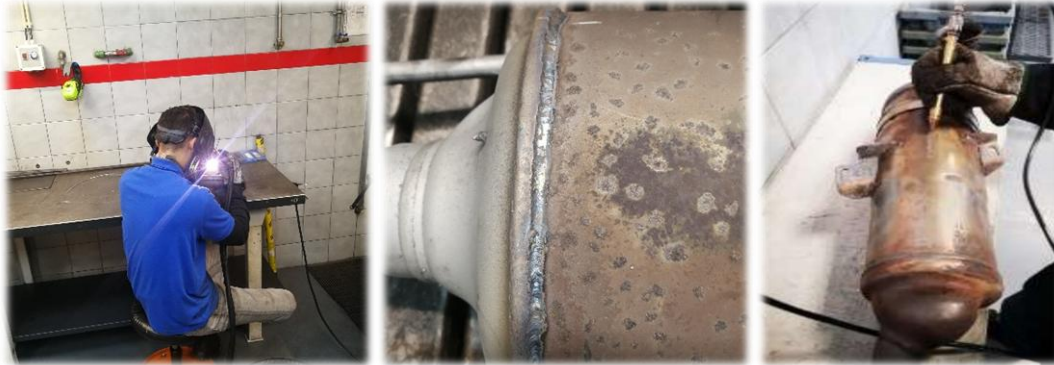
Figura 65 – Soldadura TIG e marcação do FAP.
