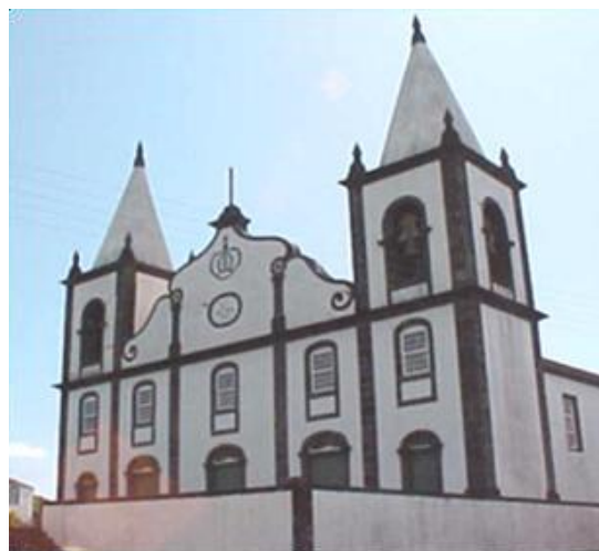
Figura 13 - Igreja de Nossa Senhora da Boa Nova, freguesia das Bandeiras, atingida pelo sismo de 1998 [7].
