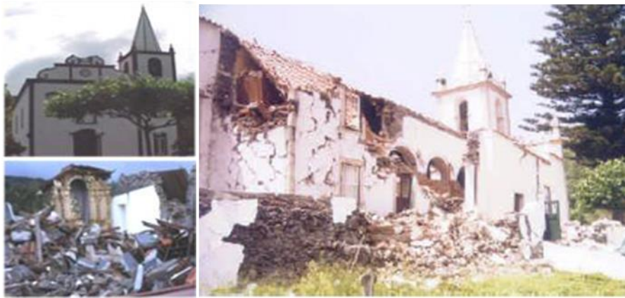
Figura 1 - Igrejas danificadas pelo sismo de 1998 [10].
