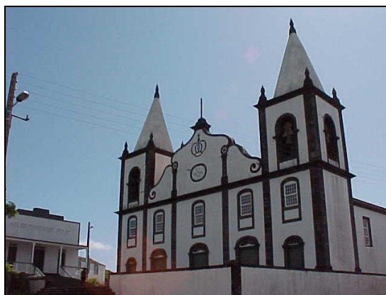
Figura 62 - Vista geral da igreja das Bandeiras [32].
