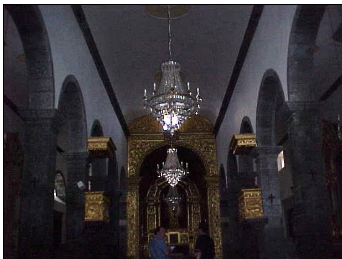
Figura 59 – Arcos de apoio às naves laterais e central [31].
