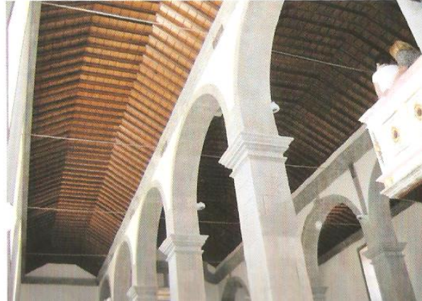
Figura 30 – Exemplo de uma cobertura recuperada após o sismo e durante a recuperação [21].
