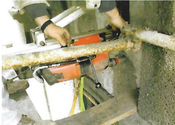
Figura 72 - Furação de alvenarias para colocação do ligador [21].
