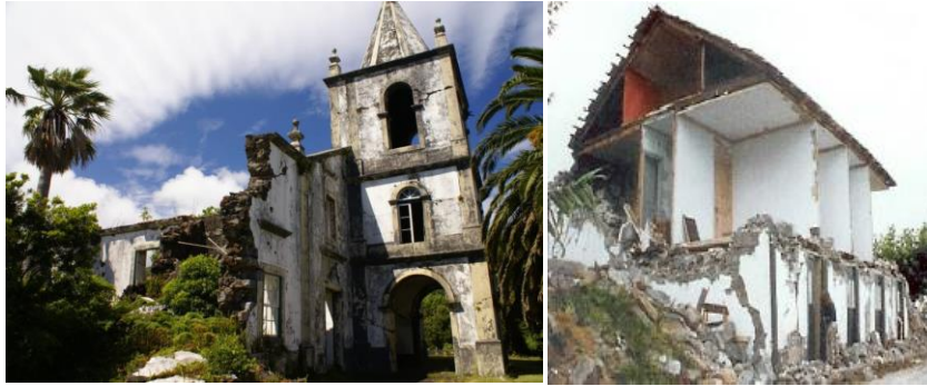
Figura 3 - Imagens de destruição total do sismo de 1998 [3,24].
