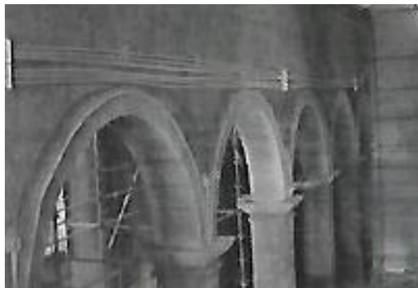
Figura 76 - Pedras à vista nos arcos [21].
