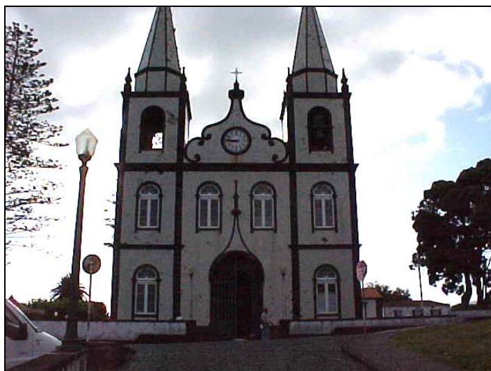
Figura 57 - Vista geral da igreja da Madalena [31].
