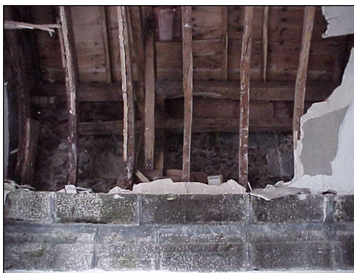
Figura 61 - Apoios intermédios da estrutura da cobertura [31].
