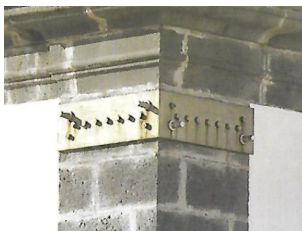
Figura 92 - Amarração em aço inox dos tirantes de travamento [21].
