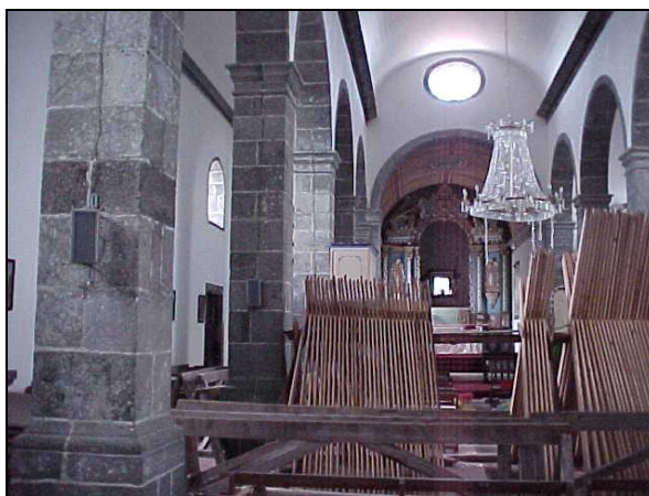
Figura 64 - Arcos de apoio às naves laterais e centrais [32].
