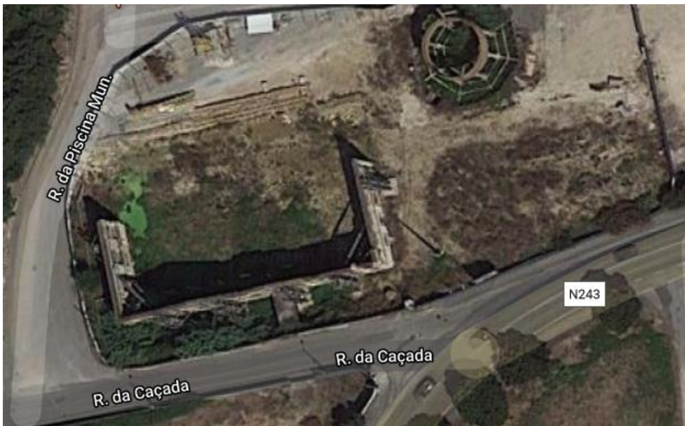
Figura 1 – Vista aérea da zona de intervenção com as paredes de fachada do edifício original (fonte Google Maps)
