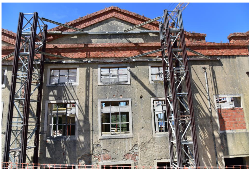
Figura 3 – Vista da fachada sul do edifício original.
