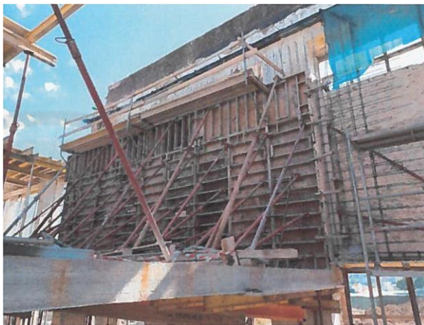
Figura 6 – Execução da parede de BA adjacente à parede de alvenaria nascente
