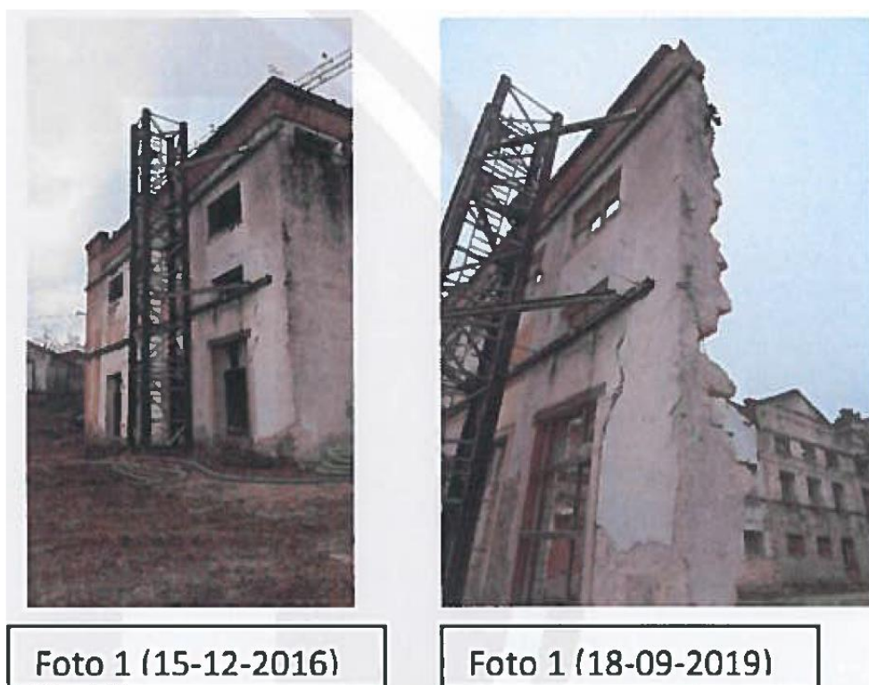
Figura 4 – Imagens do cunhal entre a parede nascente e norte antes e depois dos trabalhos preparatórios da obra 1
