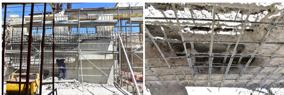
Figura 15 – Parede a demolir
