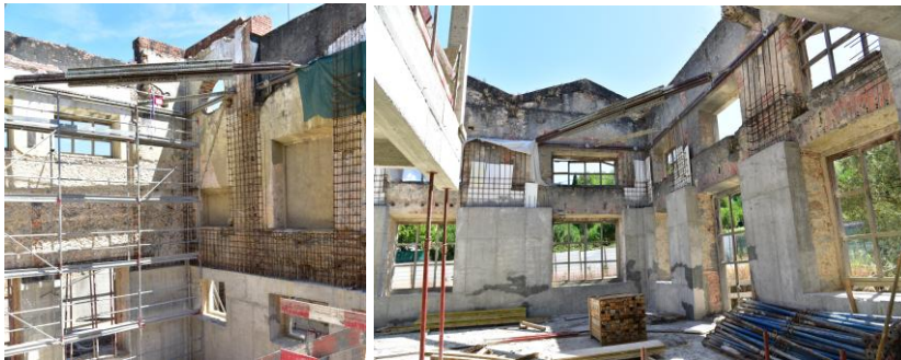
Figura 10 – Vista interior fachada sul
