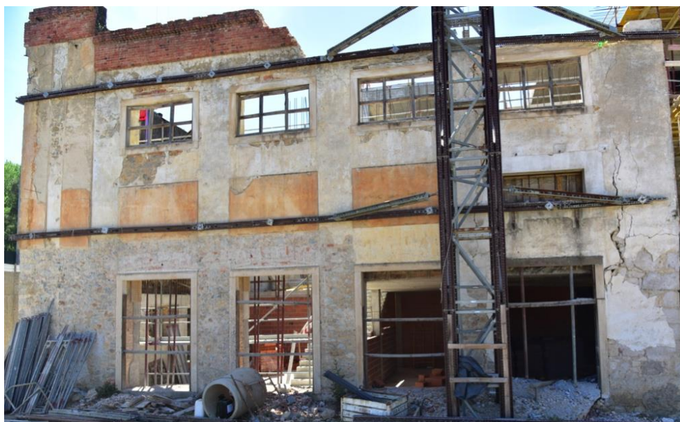
Figura 2 – Vista da fachada nascente do edifício original.
