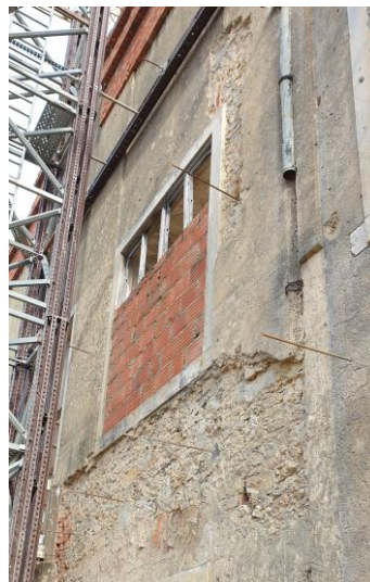
Figura 13 – Detalhe dos conectores executados
