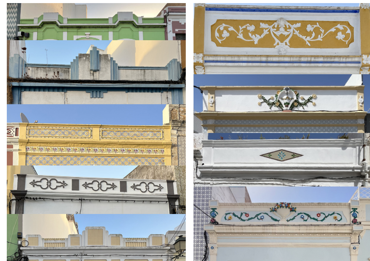
Fig. 72 - Platibandas de Portimão e Fuseta para efeitos de comparação, 2025. Fonte: autoria própria
