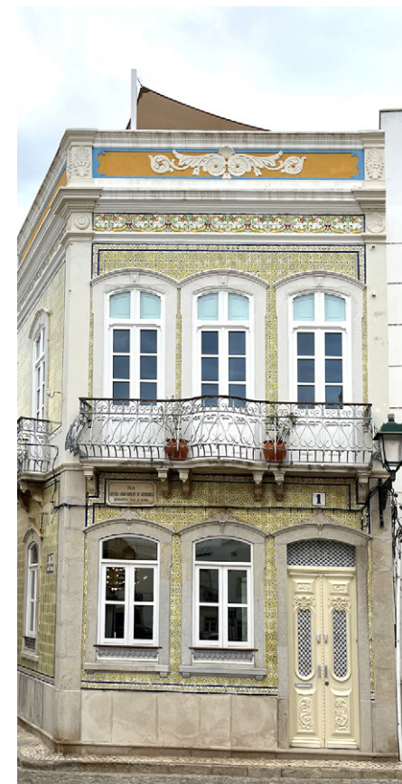
Fig. 20 - Fachada com platibanda decorada, Olhão, 2025. Fonte: autoria própria
