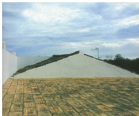
Fig. 12 - Face interna da platibanda Fonte: "Os stuccos exteriores na região do Algarve", por M. Santos, 2016, p. 17.
