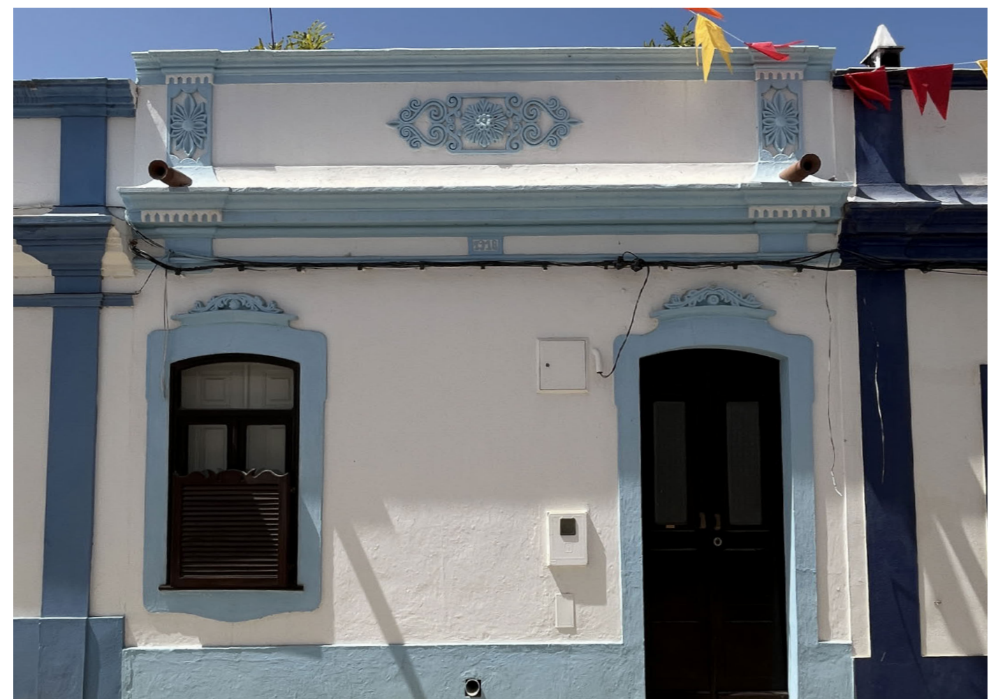
Fig. 24 - Fachada com platibanda decorada, Cancela Velha, 2025. Fonte: autoria própria
