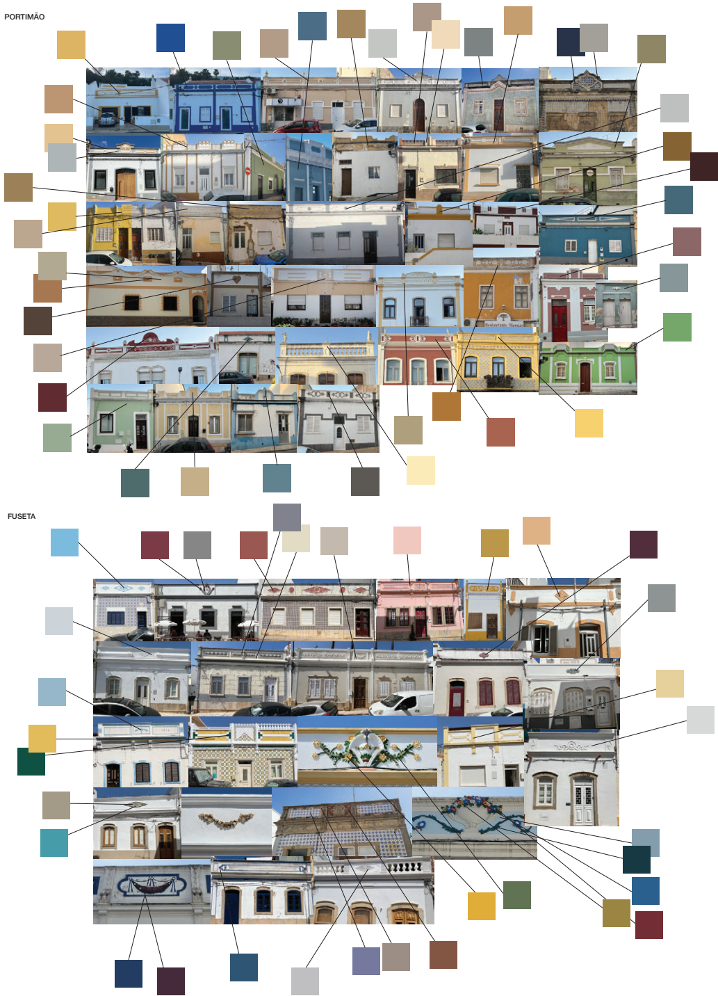
Fig. 79 - Levantamento cromático das platibandas das zonas de Portimão e Fuseta. Fonte: autoria própria
