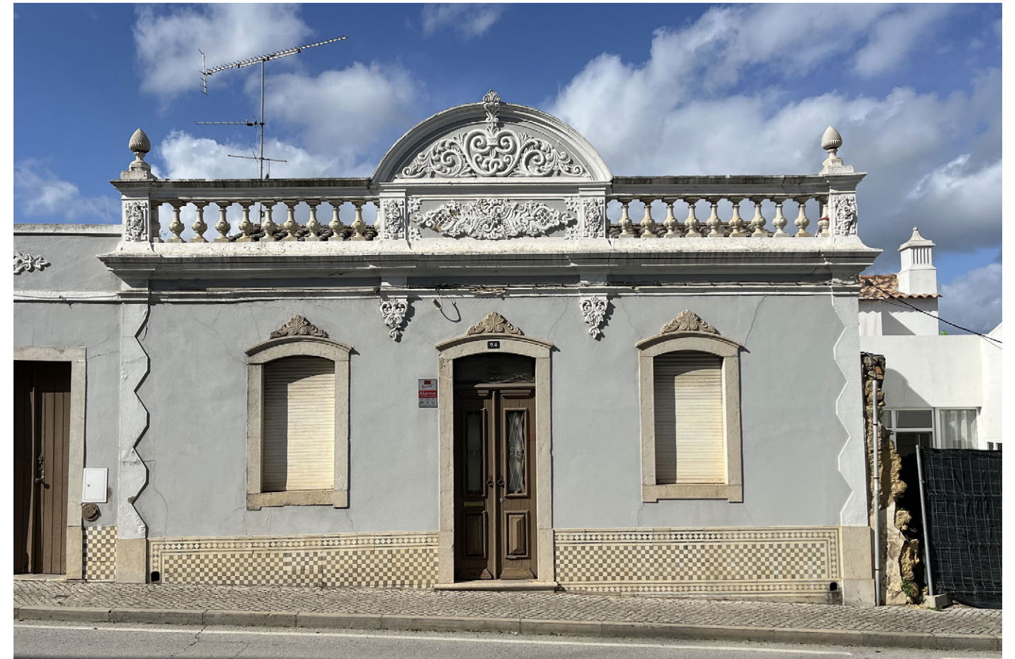
Fig. 10 - Fachada com platibanda decorada, Tavira, 2025. Fonte: autoria própria
