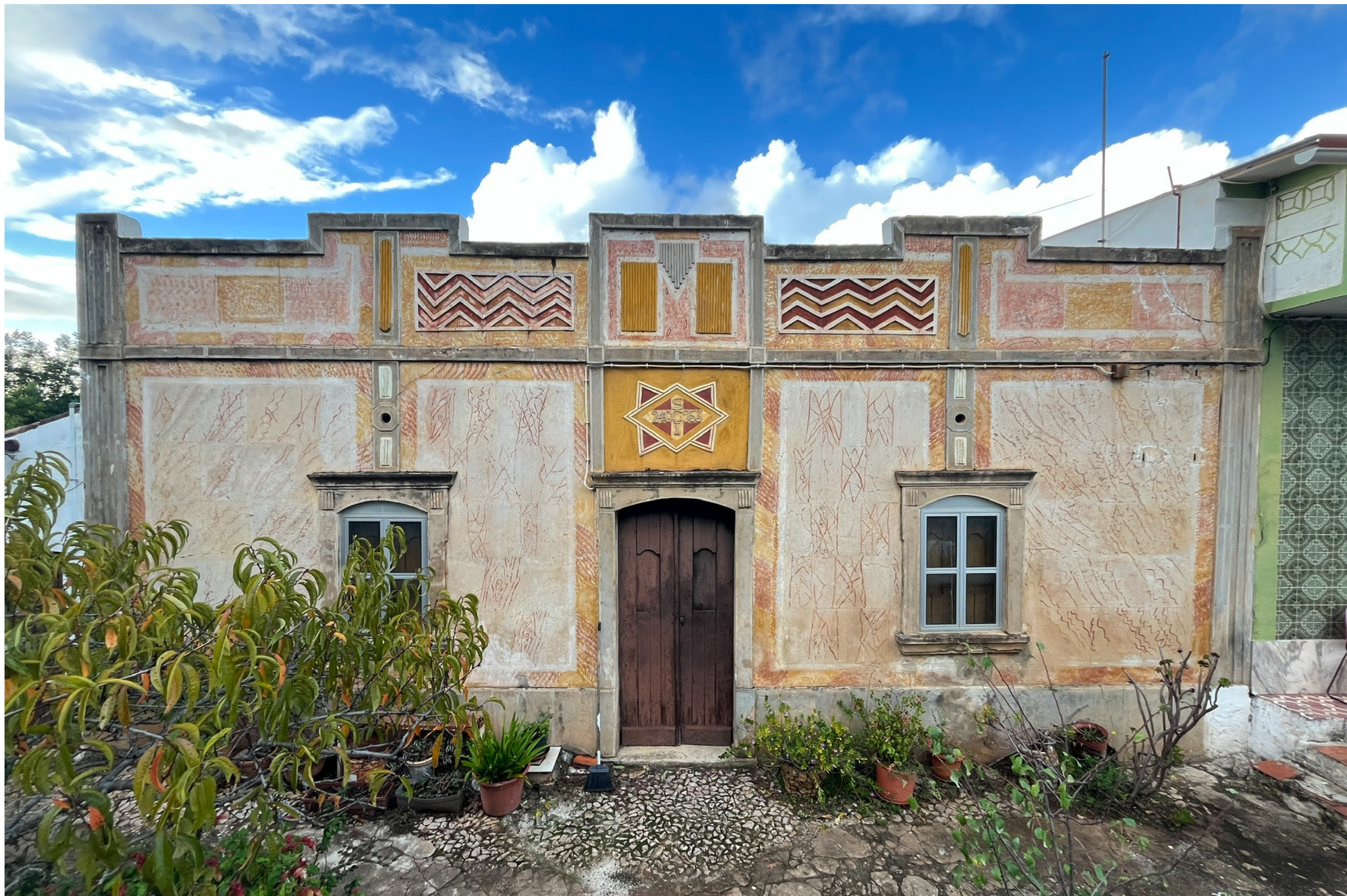
Fig. 63 - Fachada e platibanda decorada em escaiola, Loulé, 2025. Fonte: autoria própria
