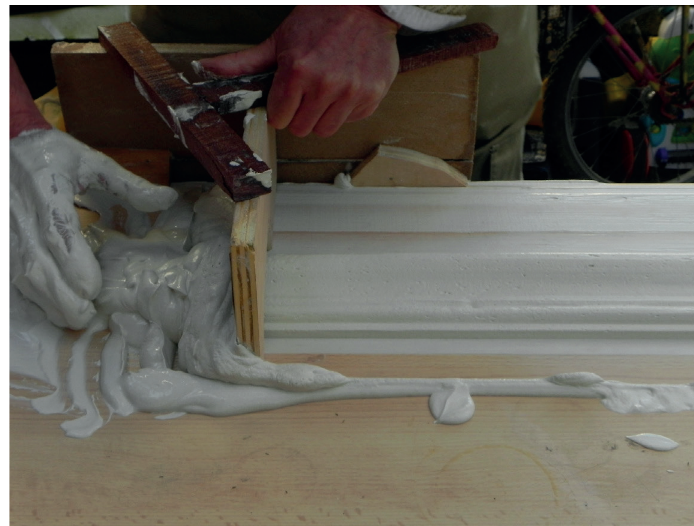
Fig. 18 - Execução de trabalho de massa com recurso a "molde de correr". Fonte: "Os stuccos exteriores na região do Algarve", por M. Santos, 2016, p. 18.
