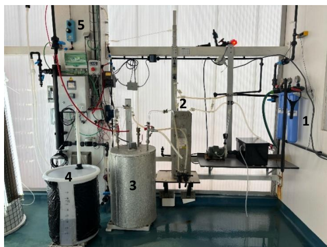
Figura 25 - Estação de tratamento da água da sala dos sacos. 1. Filtros de cartucho; 2. Permutador; 3. Pasteurizador; 4. Tanque dos nutrientes; 5. Injeção de dióxido de carbono ( \text{CO}_2 ).
