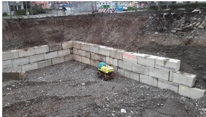
Figura 6 - Blocos de contenção de terras [4]
