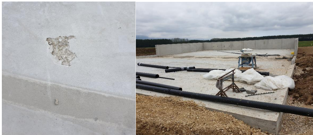
Figura 11 - Ensoleiramento geral assente em estacas
