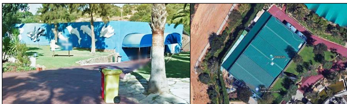
Figura 1.1.5-1 - Edifício Oceanus (Aquário) do Zoomarine Algarve, vista de perspectiva e aérea do edifício, respetivamente.
