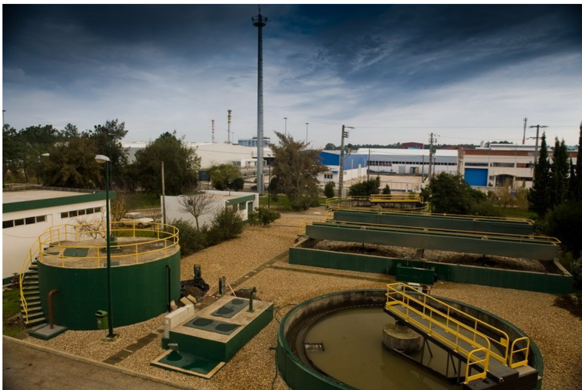
Figura 9 - Imagem geral, ETAR de Zona Industrial da Marinha Grande (SIMLIS, 2014)
