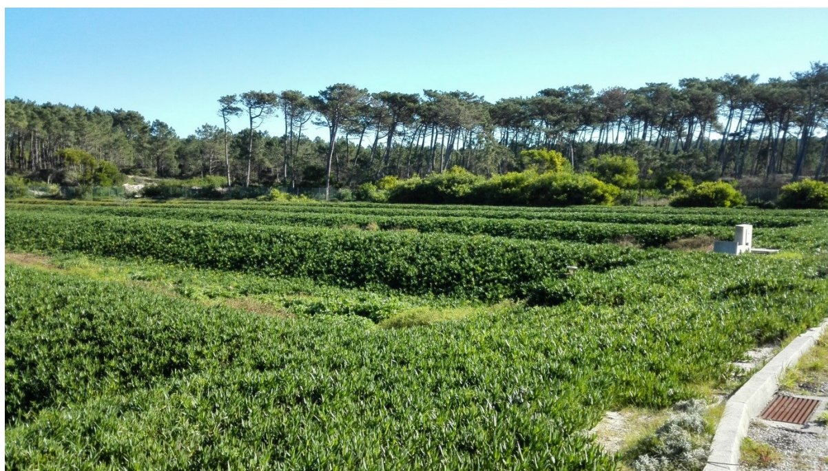
Figura 22 - Trincheiras de infiltração, ETAR de S. Pedro de Moel (SIMLIS, 2014)
