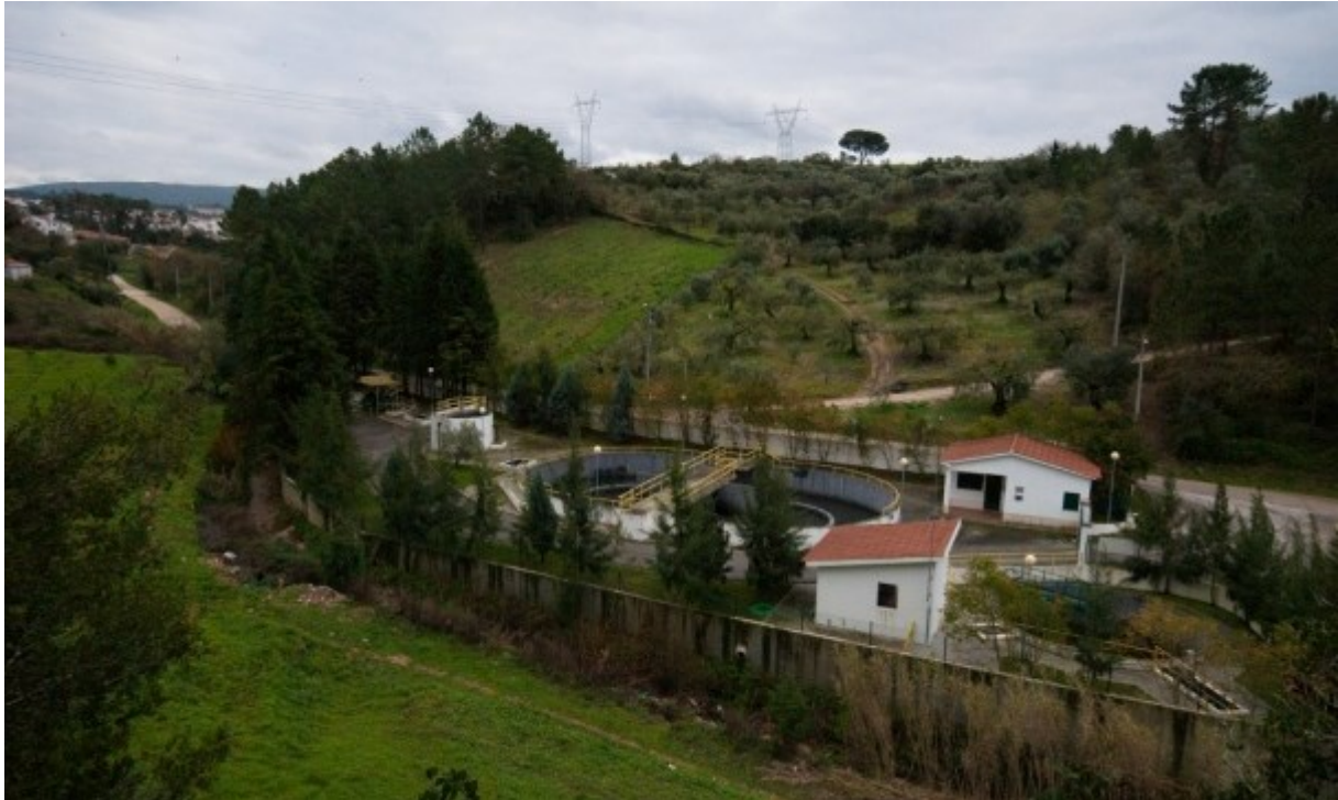
Figura 11 - Imagem geral, ETAR de Juncal (SIMLIS, 2008)
