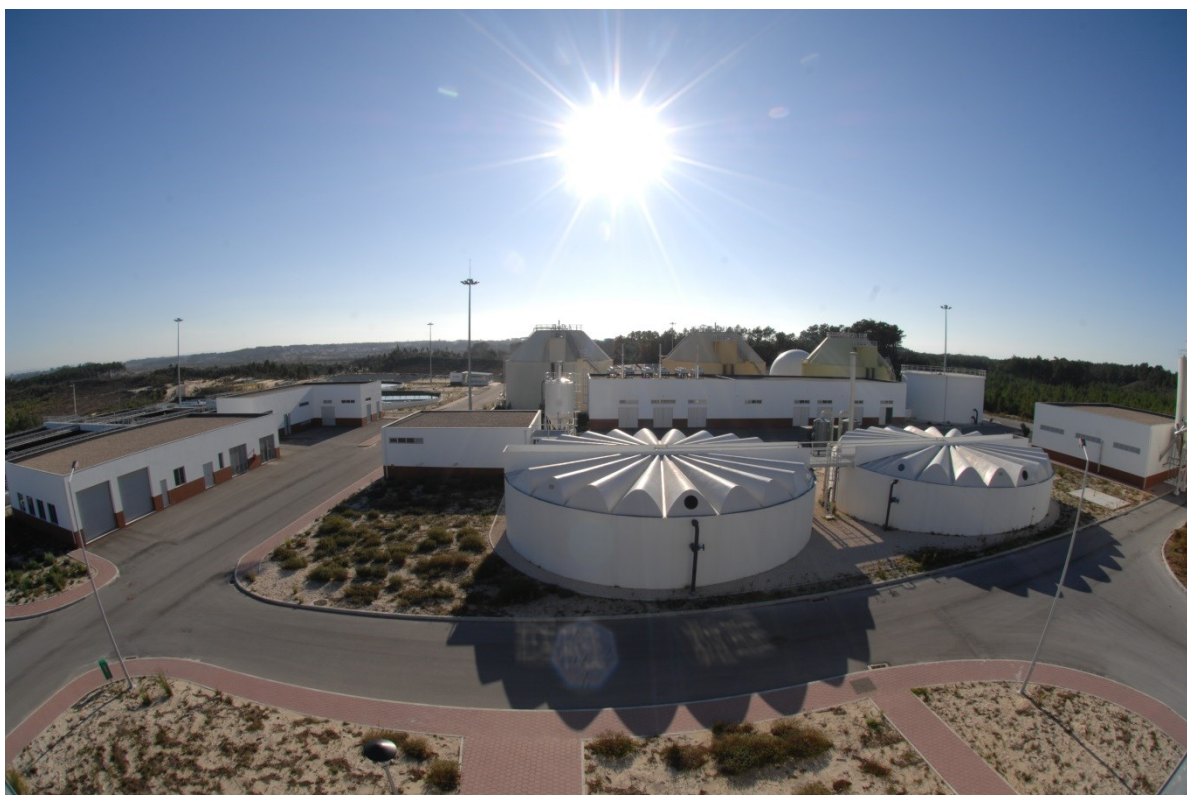
Figura 2- Imagem geral, ETAR Norte (SIMLIS, 2012).
