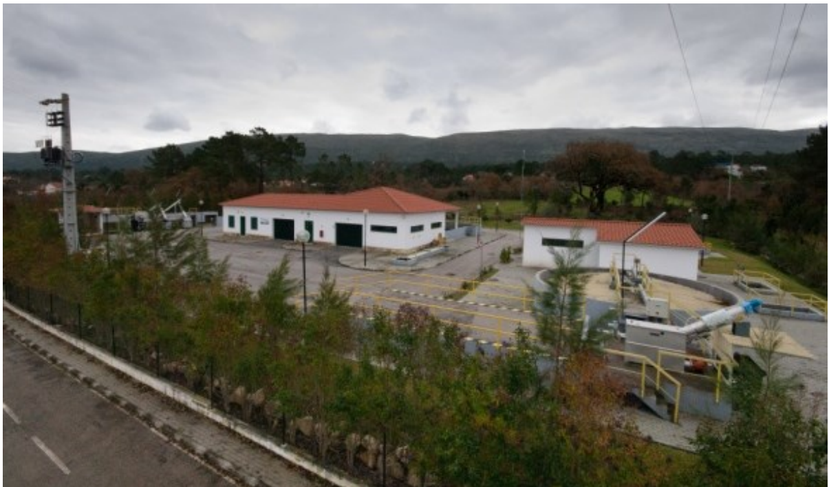
Figura 15 - Imagem geral, ETAR de Pedreiras (SIMLIS, 2008)
