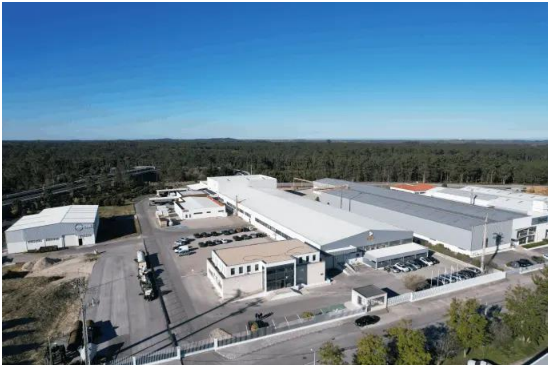
Figura 4 - Instalações atuais da HRV
