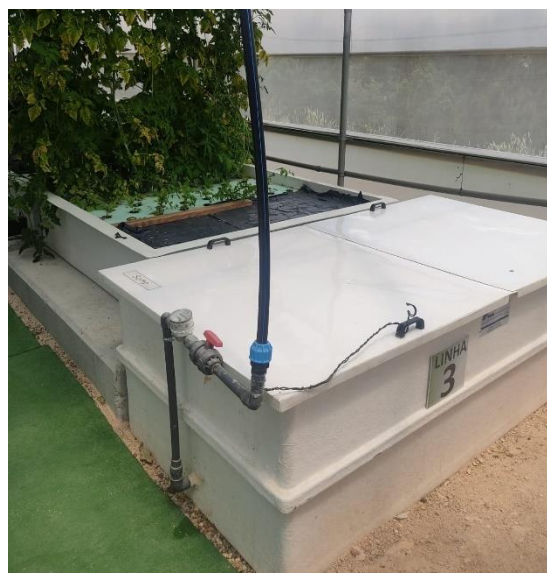
Figura 10- Estrutura Geral do Sump
