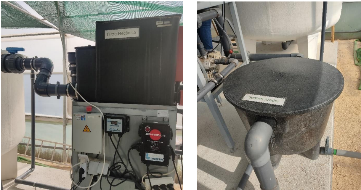
Figura 7- Filtro Mecânico e Sedimentador no Sistema de Aquaponia
