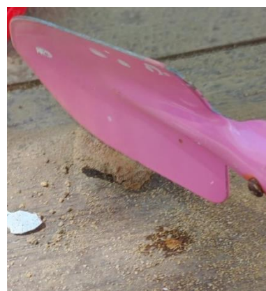
Imagem 1: Na cozinha de lama estava a partir bocados de terra – que se formaram por causa da chuva.
