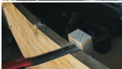
Figura A72 Corte dos excedentes das travessas do banco do remador
