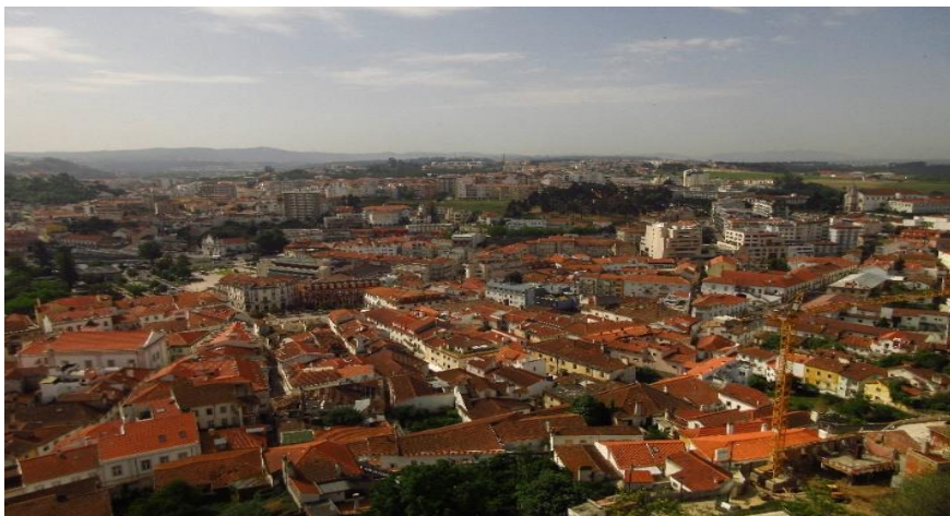
Figura 30 - Coberturas do centro histórico
