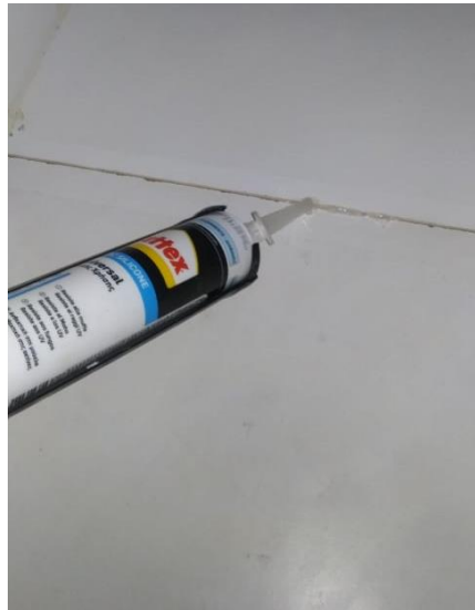
Figura 3.15 – Isolamento de frestas menos espaçadas com silicone.
