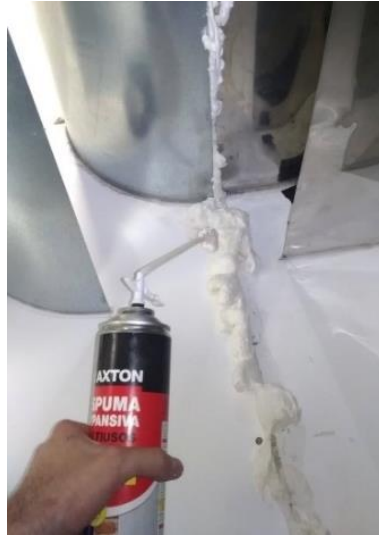
Figura 3.14 – Isolamento de frestas mais espaçadas com espuma poliuretano.
