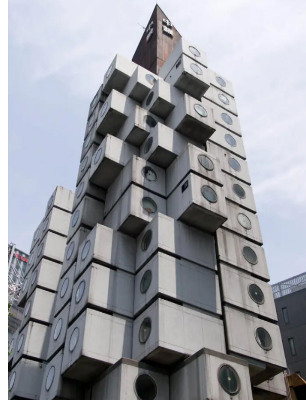
FIG. 14 Vista exterior do edifício Nakagin Capsule Tower.
