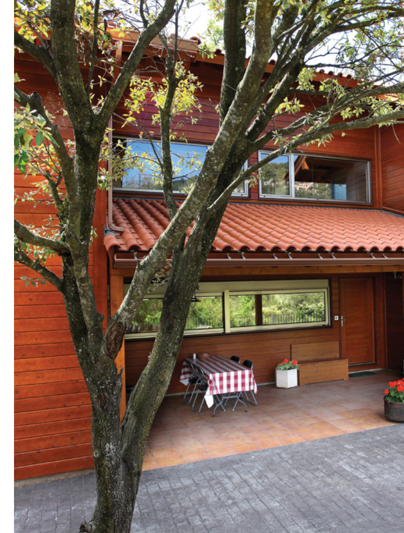
Para a estrutura e revestimentos foram utilizados pladur, pinho e abeto nórdicos
