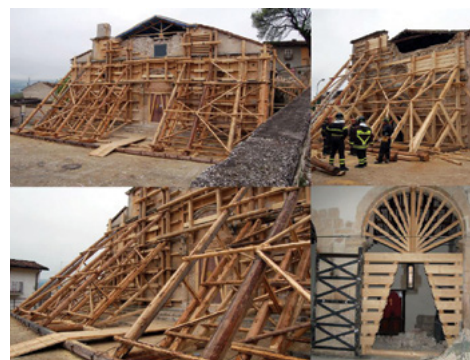
Figura 1: Estruturas temporárias de madeira aplicadas em L'Aquila (www.vigilfuoco.it)
