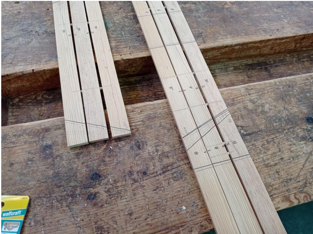
Imagem 18: Processo construção passadeira
