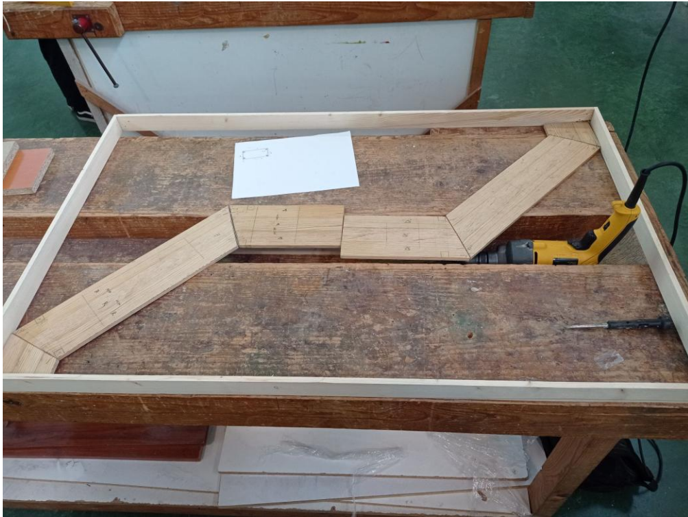
Imagem 21: Processo construção passareira
