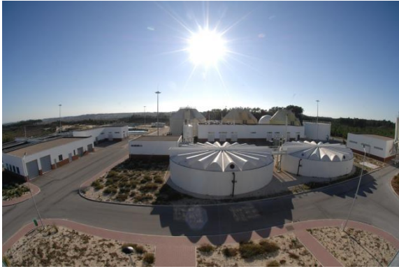
Figura 2 - Imagem aérea da ETAR Norte (Águas do Centro Litoral, S.A., 2015)
