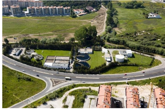
Figura 3 - Imagem aérea da ETAR de Olhalvas (Águas do Centro Litoral, S.A., 2015)
