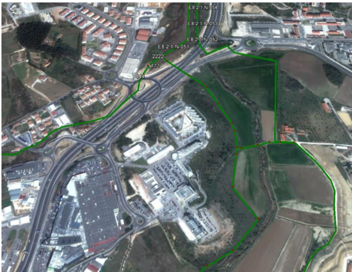
Figura 7 - Troços do emissário sem qualquer caixa de visita
