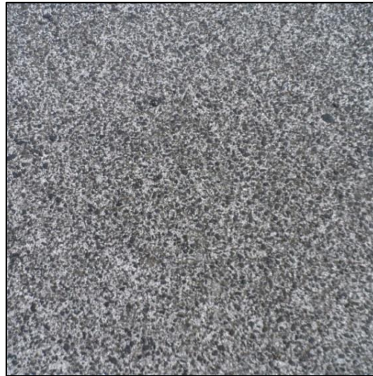
Figura 50 - Padrão do pavimento de estrada em asfalto - R2.
