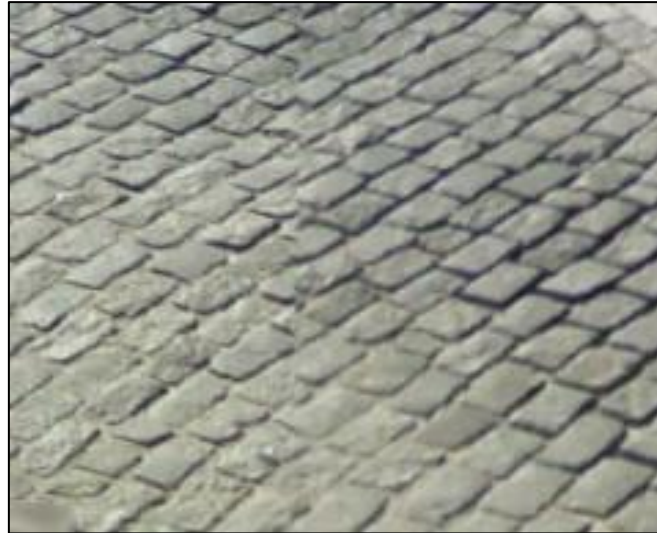
Figura 56 - Padrão do pavimento em granito paralelepípedo 20x10 cm - R5
