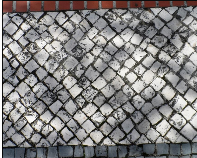
Figura 54 - Padrão do pavimento em calçada a portuguesa - R4.
