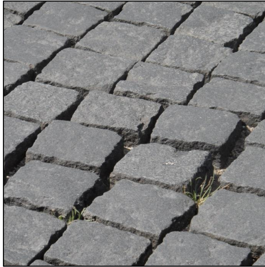
Figura 58 - Padrão do pavimento em granito paralelepípedo 10x10 cm - R6
