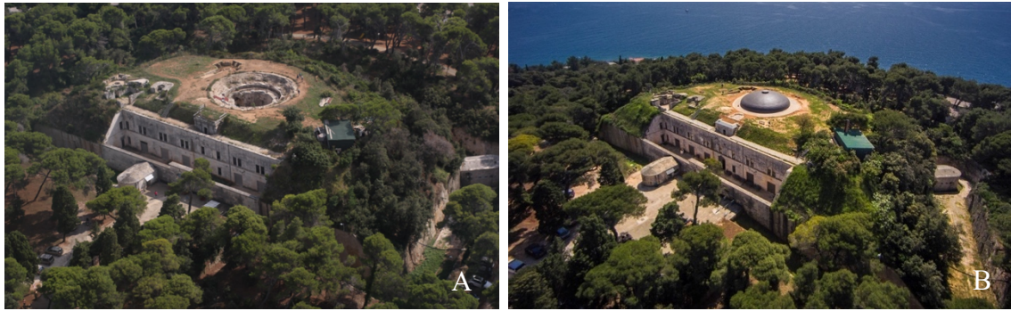
Figura 7 – (A) Aspeto inicial da estrutura externa do Aquário de Pula; (B) Aspeto final da estrutura externa do Aquário de Pula.
