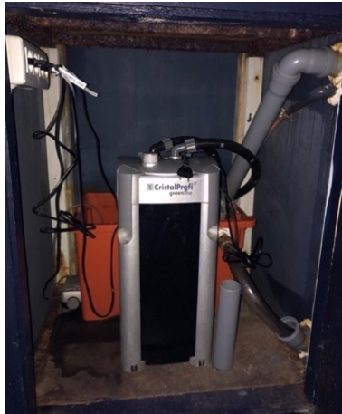
Figura 41 - Compartimento com sistema de filtração do aquário.
