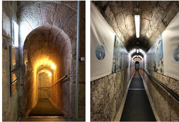
Figura 25 - Túneis de acesso ao piso -1.
