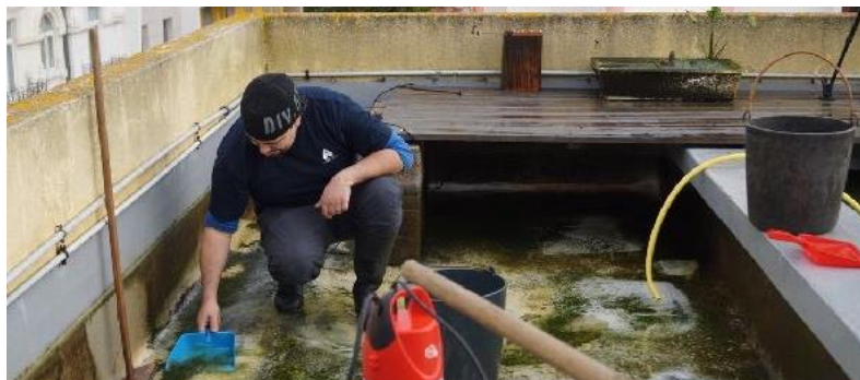
Figura 3 - Limpeza da camada de lodo que fica no fundo.
