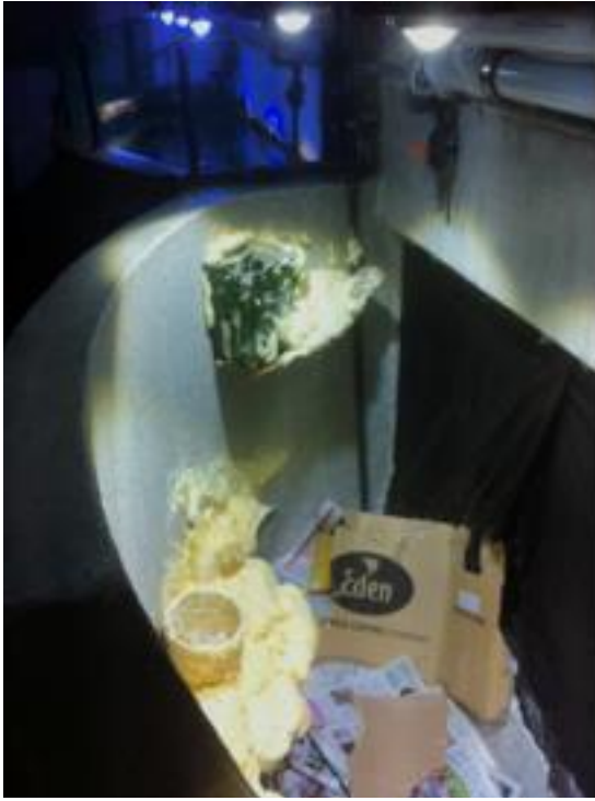
Figura 9 - Início da reconstrução da decoração, recorrendo a espuma de poliuretano expandido e massa de juntas. Após a aplicação do poliuretano, este é moldado e depois coberto com um impermeabilizante.
