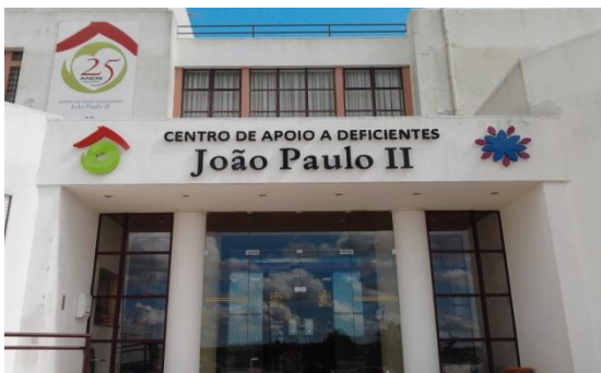
Figura 4: Centro de Apoio a Deficientes João Paulo II
