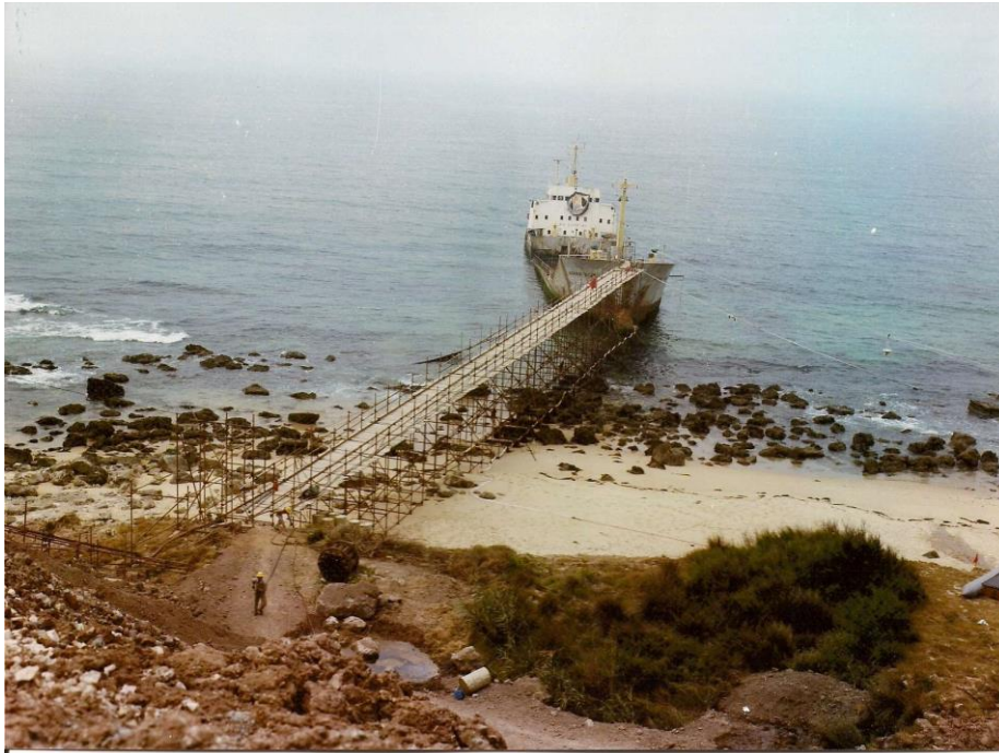
Figura 3.20. Plataforma de recuperação do navio “MV Alchemist Emden”
