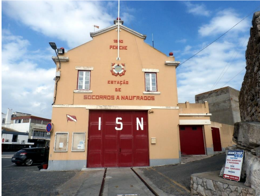
Figura 3.15. Estação de Socorros a Náfragos de Peniche
