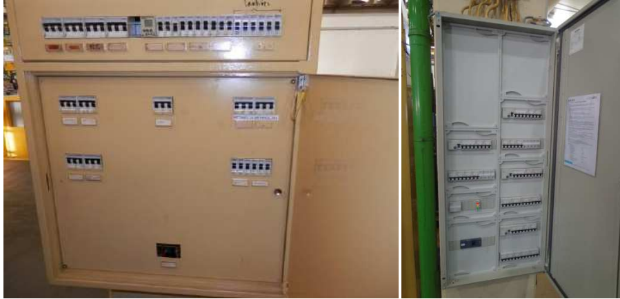
Figura 4.14 - Substituição de QE sem proteção-diferencial.
