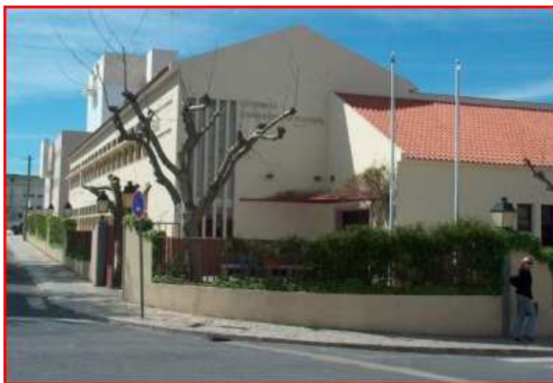
Figura 4: Edifício principal do Externato Cooperativo da Benedita
