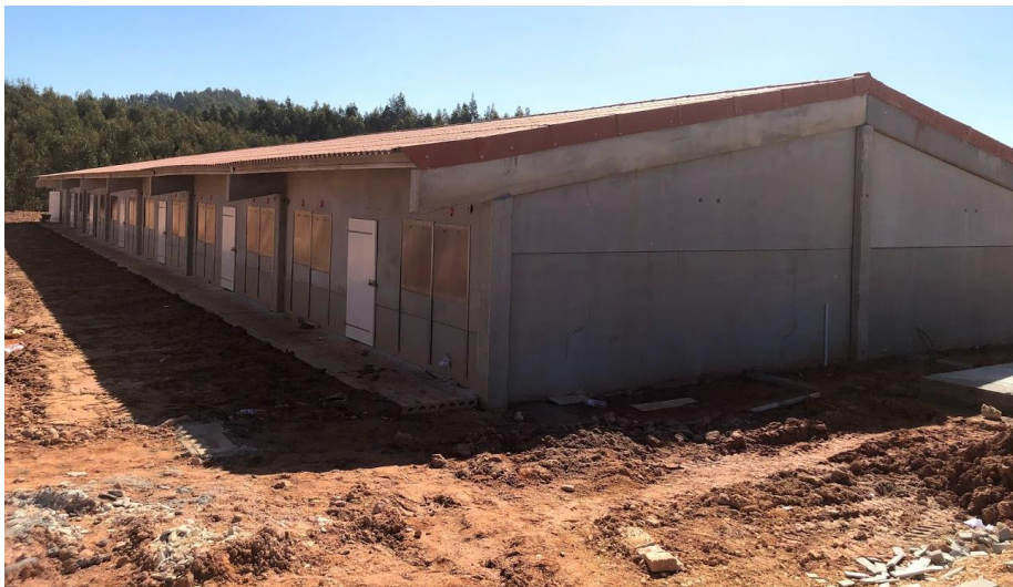
Figura 16: Pavilhão de engorda construído, antes da instalação das mangas de acesso.
