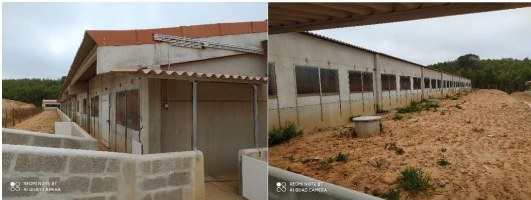
Figura 17: Pavilhões de engorda, obra executada pela empresa.
