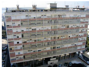
Figura A – Caso de Estudo - Edifício Lisboa.
