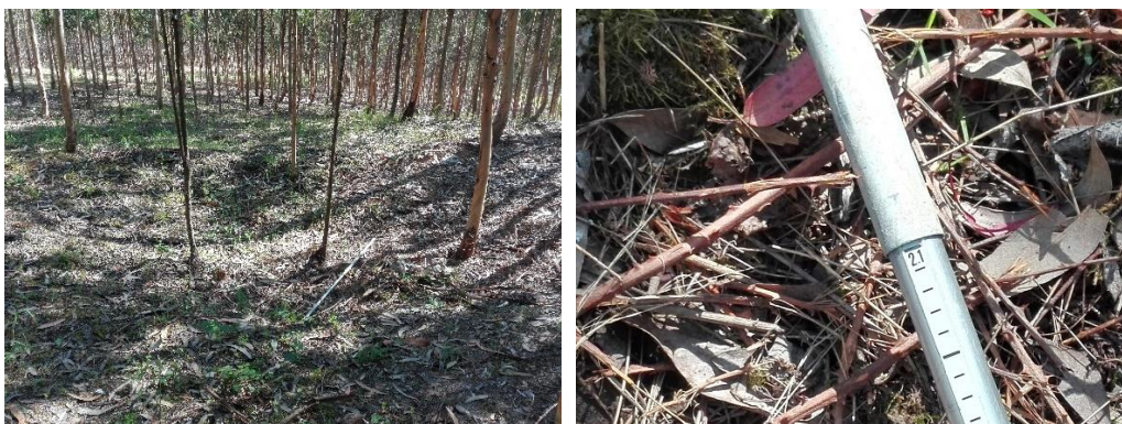
Figura 46 e Figura 47- Subsidiência verificada na Zona Z3, referente à zona do Poço dos Bogalhos, com um registo de medição de diâmetro superior a 2 metros.
