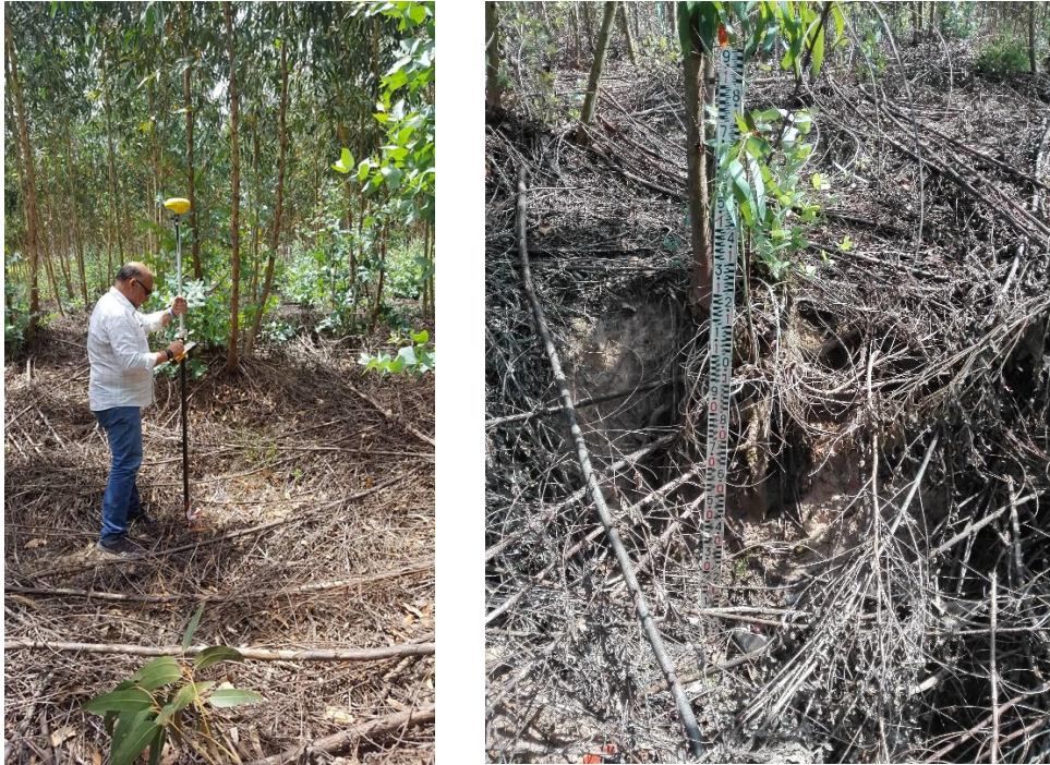
Figura 49 e Figura 50- Levantamento topográfico, georreferenciação e medições auxiliares das Subsidiências verificadas na Zona Z4
