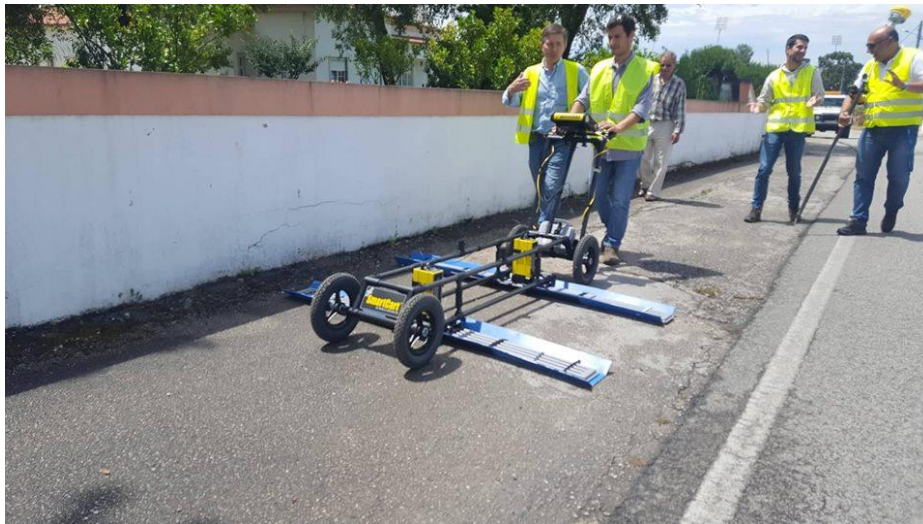
Figura 66 – Passagem do Georadar em linha, na Rua Cidade de Rio Maior – Estrada do Cidral
