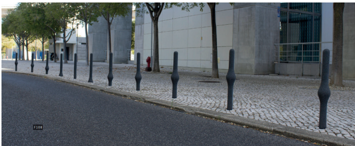
Fig. 22 - “Protótipos pilarete bolha”. (Sabino, R., 2019, Economia circular integrada na conformação de granulado de borracha (pp. 200-201))
