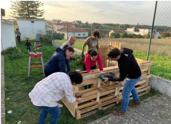
Figura 18: Dia da Construção da Cozinha de Lama
