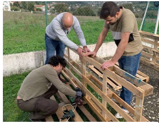
Figura 17: Pais a participar na construção da cozinha
