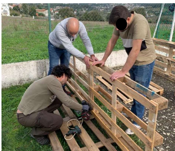
Figura 7: Construção da Cozinha de Lama
