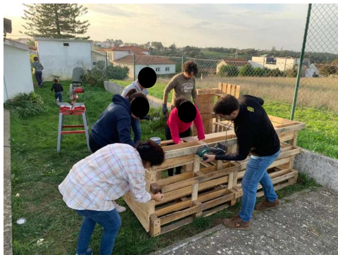
Figura 6: Construção da Cozinha de Lama
