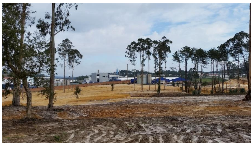
Figura 45 – Vista para Norte
