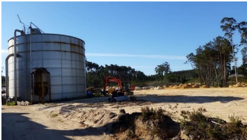
Figura 51 – Sombreamento do tanque no dia 8 de maio de 2017 às 8:46 da manhã
