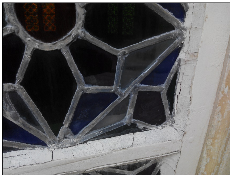
Figura 86 - Argamassa de fixação do Vital NE
