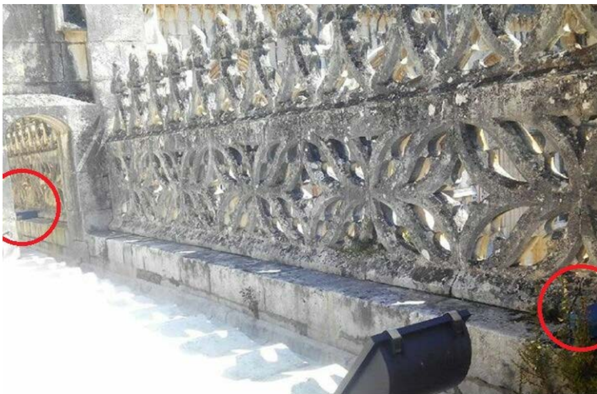
Figura 59 - Colocação de sismógrafos para identificação dinâmica ( setup 3), fixo posição "O" e móvel na posição "3"
