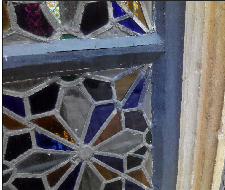
Figura 85 - Argamassa de fixação do Vital N
