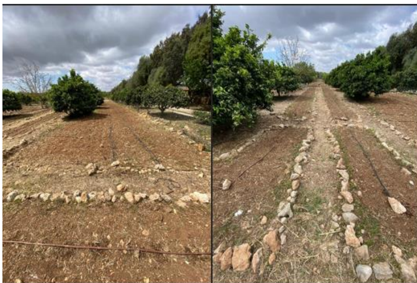
Ilustração 19 - Colocação do sistema de rego gota-a-gota.
