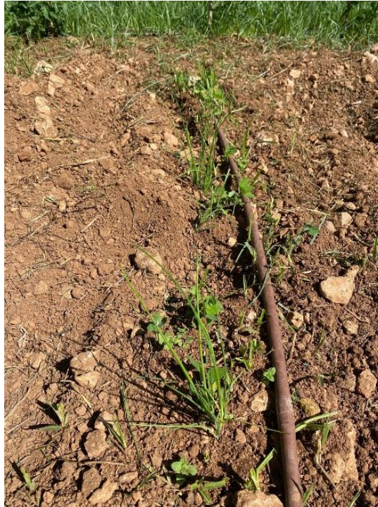
Ilustração 21 - Colocação da tubagem ao lado dos produtos.
