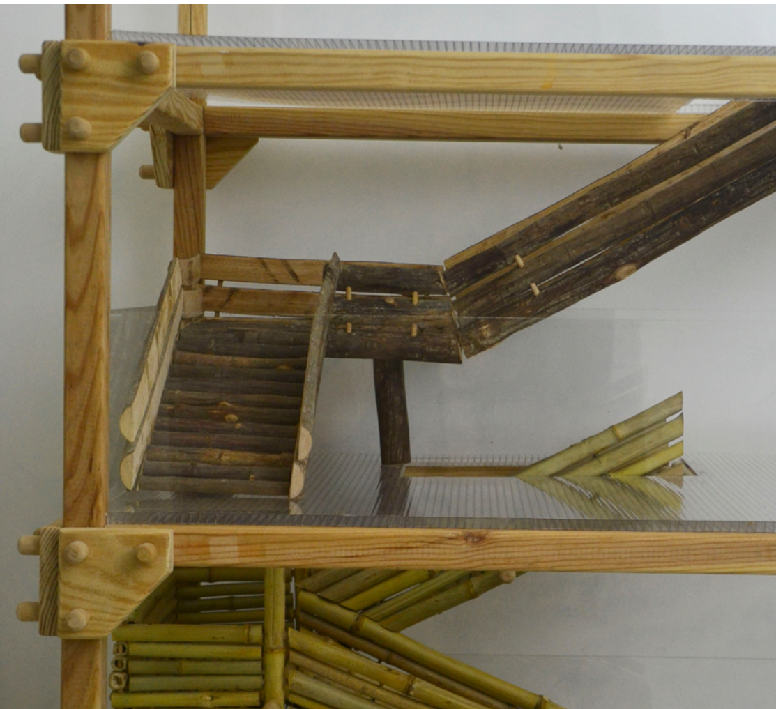
FIG. 33 Primeira estrutura, pormenor das rampas
