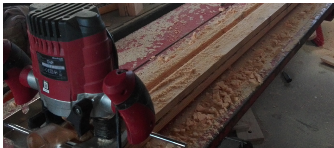
FIG. 72 Construção do perfil de recepção dos vidros
