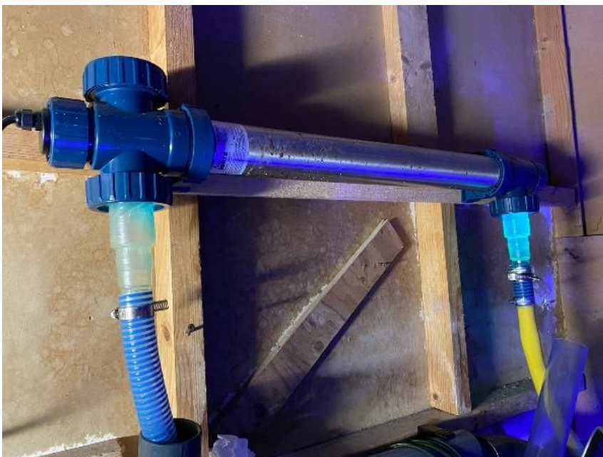
Figura 18. Exemplo de mecanismo de desinfecção da água através de luz UV
