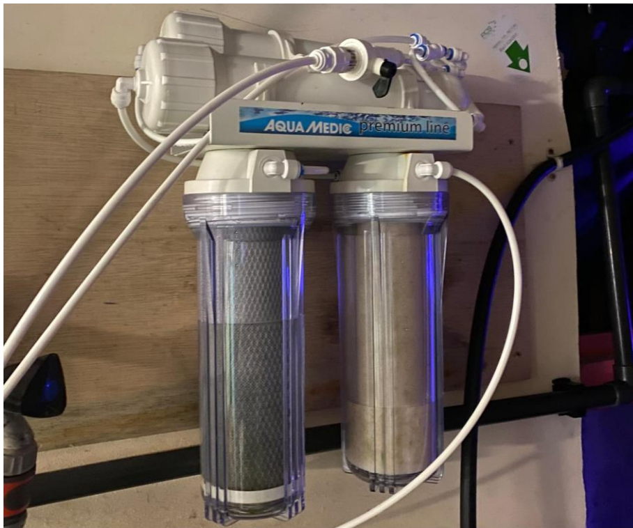
Figura 10. Equipamento de osmose inversa utilizado na produção de água purificada
