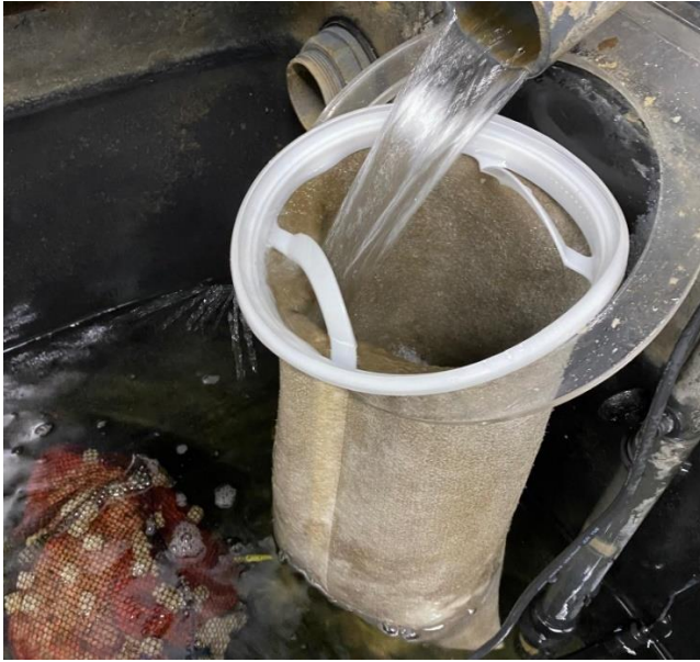
Figura 12. Exemplo de uma manga de filtração existente no SLS
