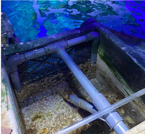
Figura 16. Exemplo de um escumador de superfície existente no SLS
