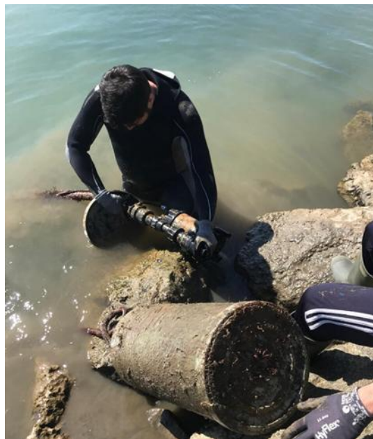
Figura 33: Limpeza de bomba hidráulica situada no porto de pesca.
