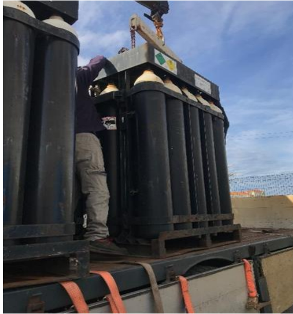
Figura 27: Substituição de um bloco de oxigénio, com o auxílio da grua.
