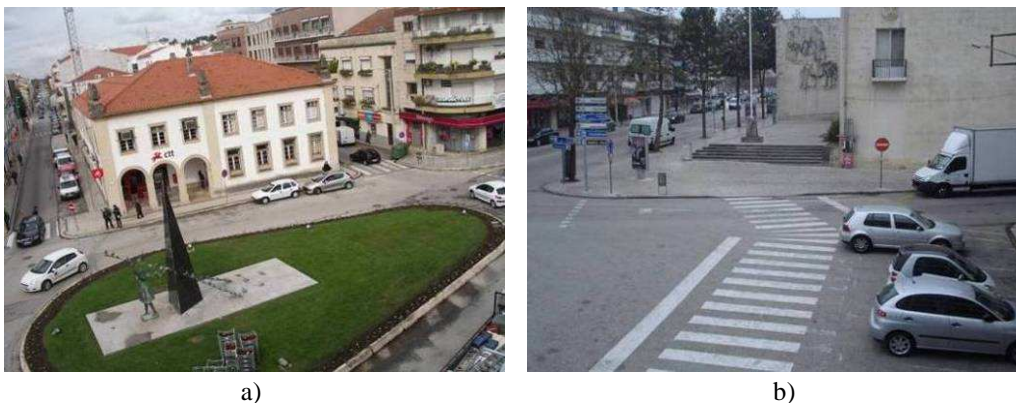
Figura 11: a) Passadeira localizada numa das saídas da rotunda; b) Zona de estacionamento e passadeira localizados no interior da rotunda Novembro 2011; Março 2012
