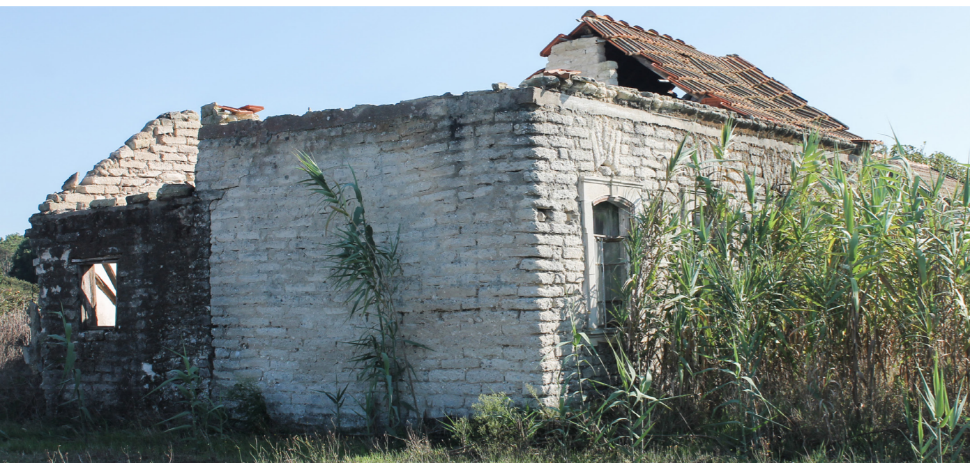
Fig. 68 Casa gandaresa com a sua estrutura em adobe visível, Praia de Mira, 2021
