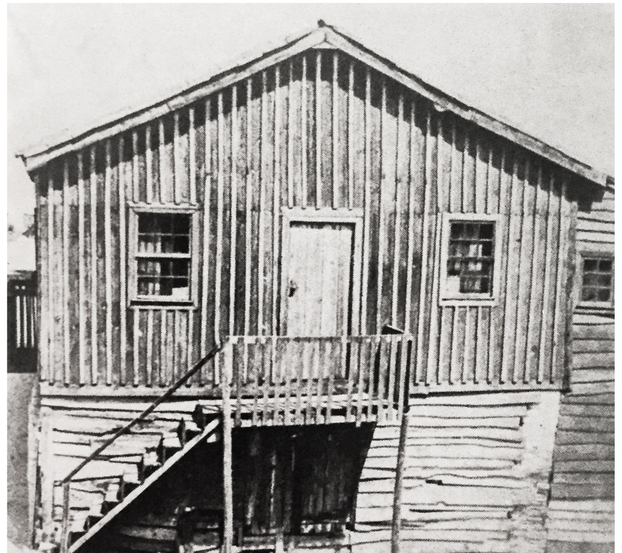
Fig. 64 Estrutura palheiros de Mira Fonte: “Palheiros de Mira: Formação e declínio de um aglomerado de pescadores” de Brito, 1981, p. 135
