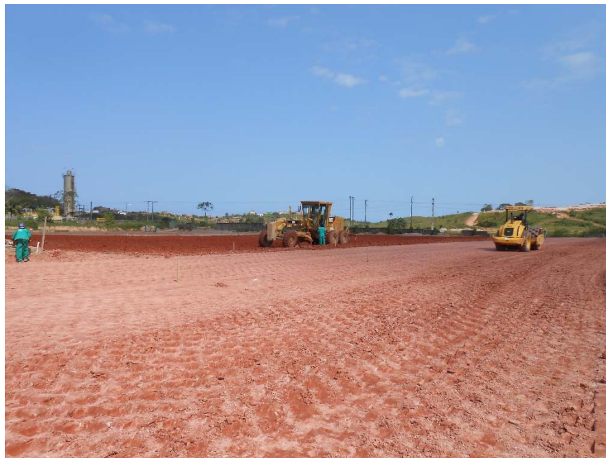
Figura 2.2 – Terraplenagem mecanizada (motoniveladora e rolo compactador)
