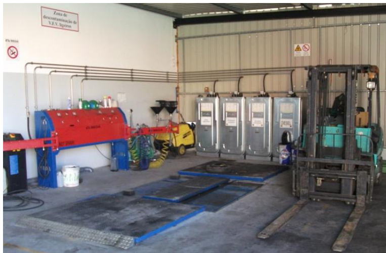
Figura 3.6 - Área de descontaminação do VFV.
