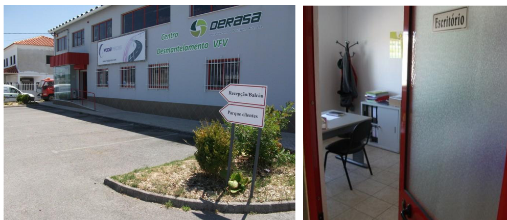
Figura 3.3 - Área receção de VFV (zona exterior e zona interior das instalações).
