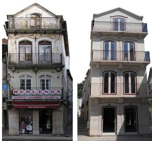
Figura 46 – Edifício “Berlenga” durante o levantamento e a restauração do mesmo.
