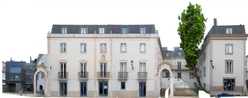
Figura 45 – Inconformidade existente entre a cartografia e o edifício real.
