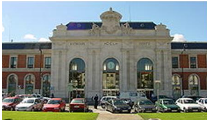
Figura 45 – Fachada da Estação de Campo Grande, Valladolid
