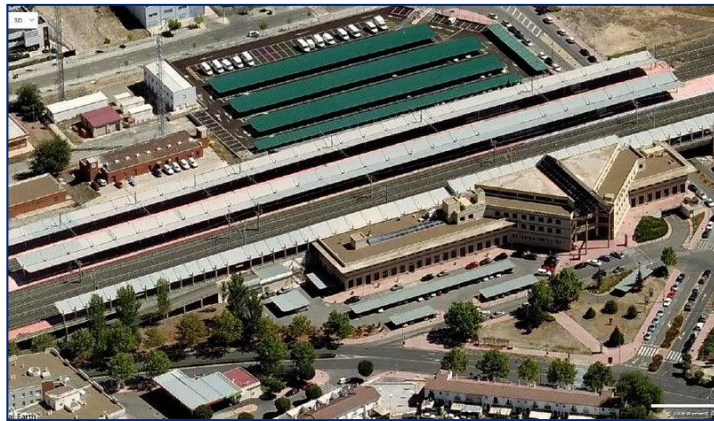
Figura 31 – Vista aérea da Estação de AV da Ciudad Real
