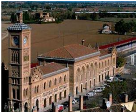
Figura 36 – Fachada da Estação de Alta Velocidade de Toledo
