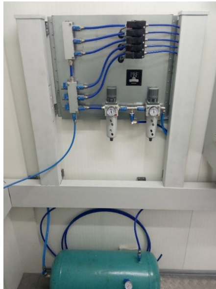
Figura 53 – Sistema de ar comprimido (retirado de (28))
