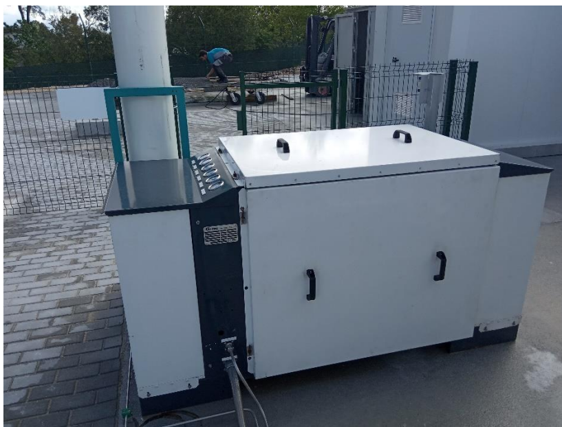
Figura 49 – Compressor de GN (retirado de (28))
