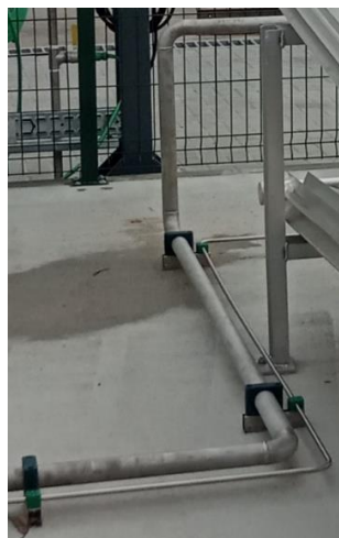
Figura 42 – Apoios implementados de acordo com o projetado (retirado de (28))
