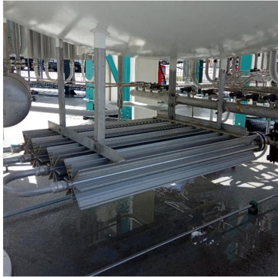
Figura 47 – Vaporizador de controlo de pressão (retirado de (28))
