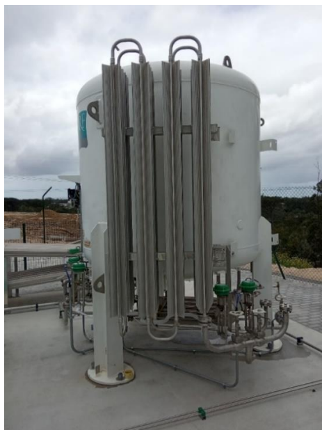
Figura 43 – Reservatório de GNL (retirado de (28))
