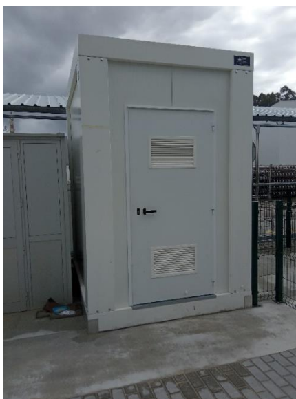
Figura 39 – Edifício de controlo (retirado de (28))
