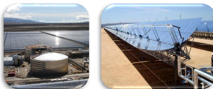
Figura 10 – Central de armazenamento de energia térmica com recurso a energia solar [14]
