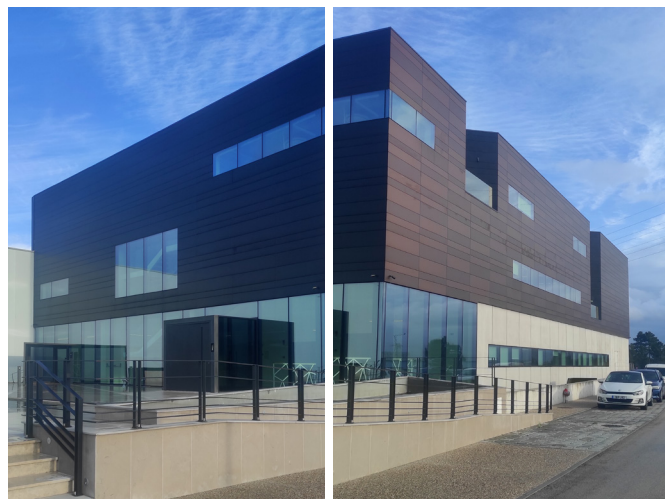
Fig. 25 Edifício pertencente ao grupo DRT, onde é sediada a Younik.
